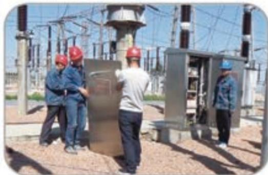
工作室成员对220kv智能变电站进行智能组件箱降温改造
