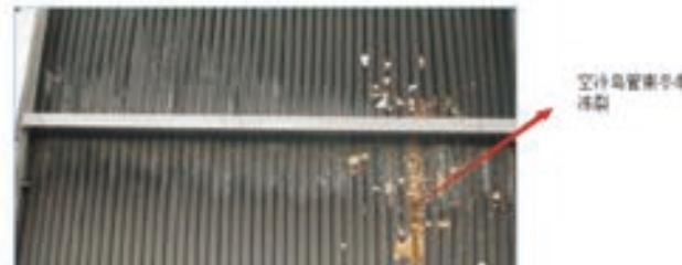
图5 某600MW超临界空冷机组逆流区相邻处散热管冻结
