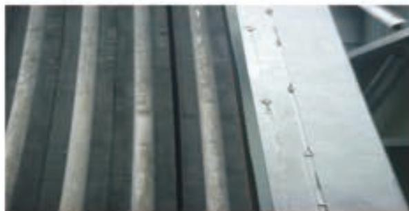
图6 空冷岛边缘散热管冻结变形
