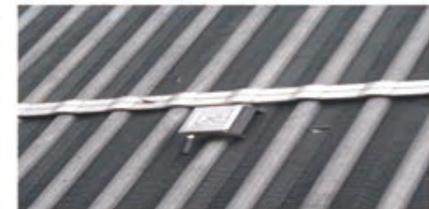
图7 空冷岛无线测温传感器安装图
